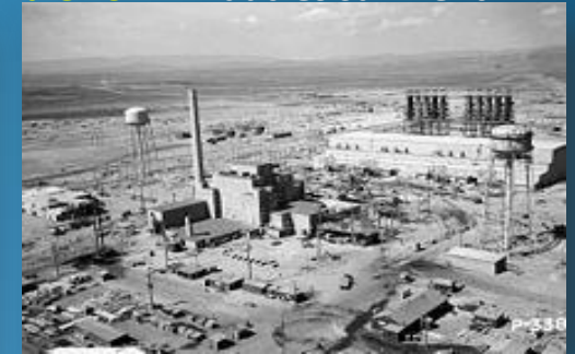
Réacteur B de HANFORD sept.1944 – Ur naturel – P < 250 MW
