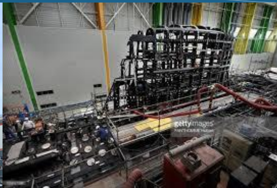
Ossature du massif vue de tribord
