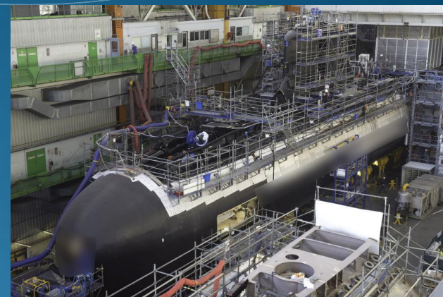
Vue d'ensemble du chantier (Noter le sas au-dessus du compartiment réacteur)
