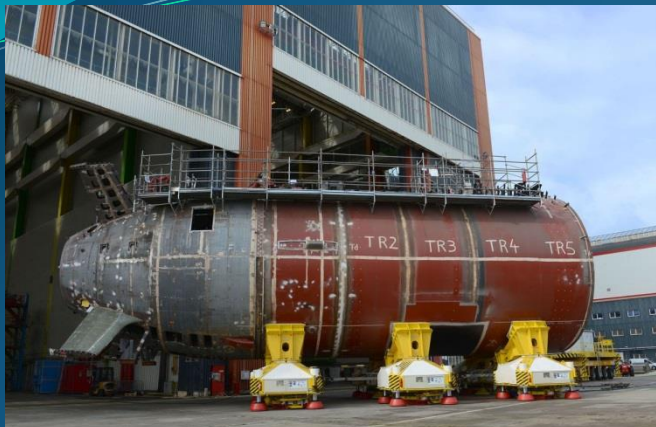
Déplacement de la section AR sur « marcheurs » (Noter les ailerons en "X" des barres de plongée AR)
